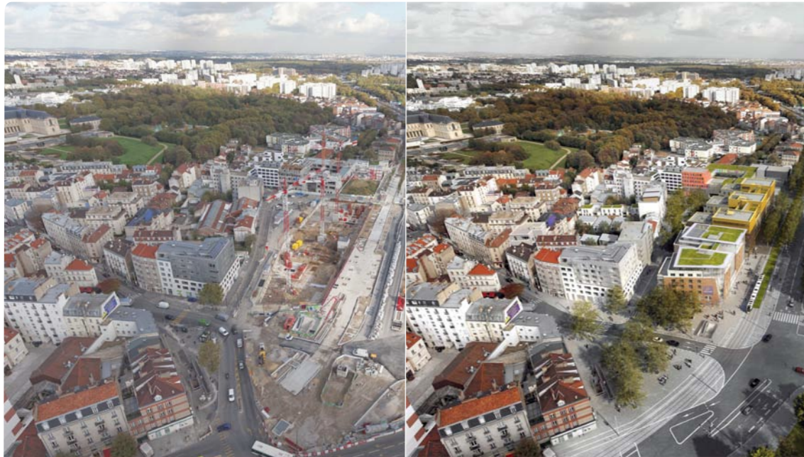
Photo de la Porte de Paris pendant ses travaux d'aménagement, décembre 2013 et perspective du quartier terminé (crédits : Didier Blavette)
