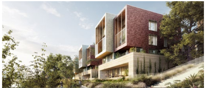
Programme de 11 logements en accession conçu par PetitDidierPrioux
