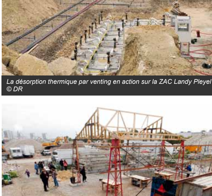
La désorption thermique par venting en action sur la ZAC Landy Pleyel © DR
