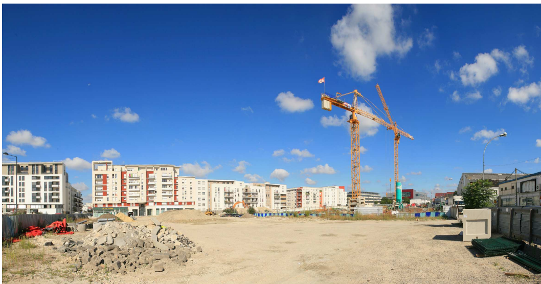
Etat actuel du chantier de la place. Photo : Paul Maurer
